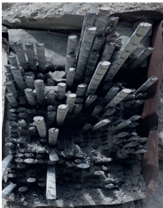
Abbildung 6.2d: zum Vergleich, spröde gebrochene Spanndrähte, ohne signifikante Korrosionsprodukte, des Spanngliedes in Träger 4
