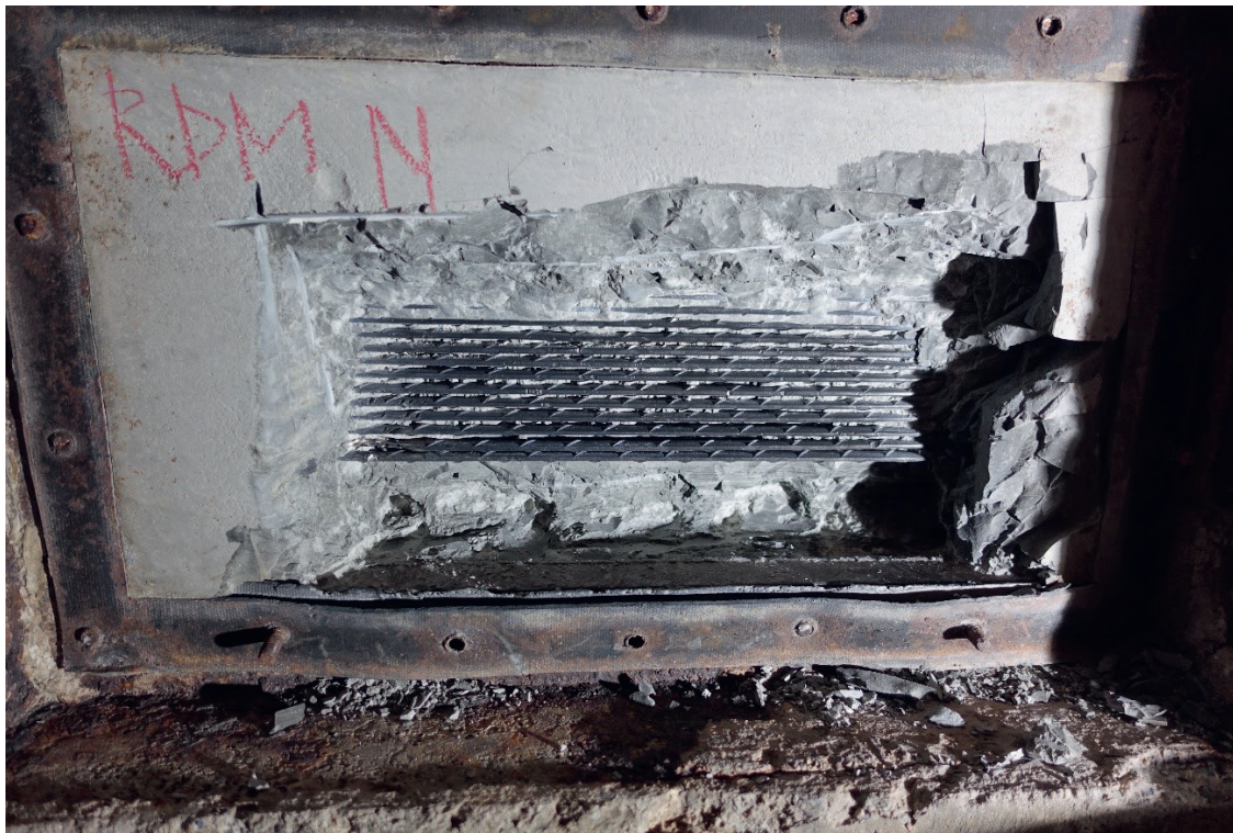
Abbildung 4.3a: Messstelle Rückdehnungsmessung Nord mit freigelegten Spanndrähten
