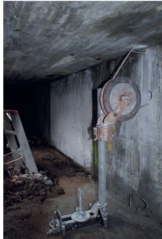
Abbildung 3.2b: Schnittstelle mit Seil auf Umlenkrolle im Hohlkasten
