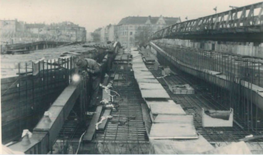
Abbildung 2.2d: Zuschweißen der Hüllkästen beim Bau der Eisenbrücke [Privatarchiv Fritz Niedergesäß, Berlin]
