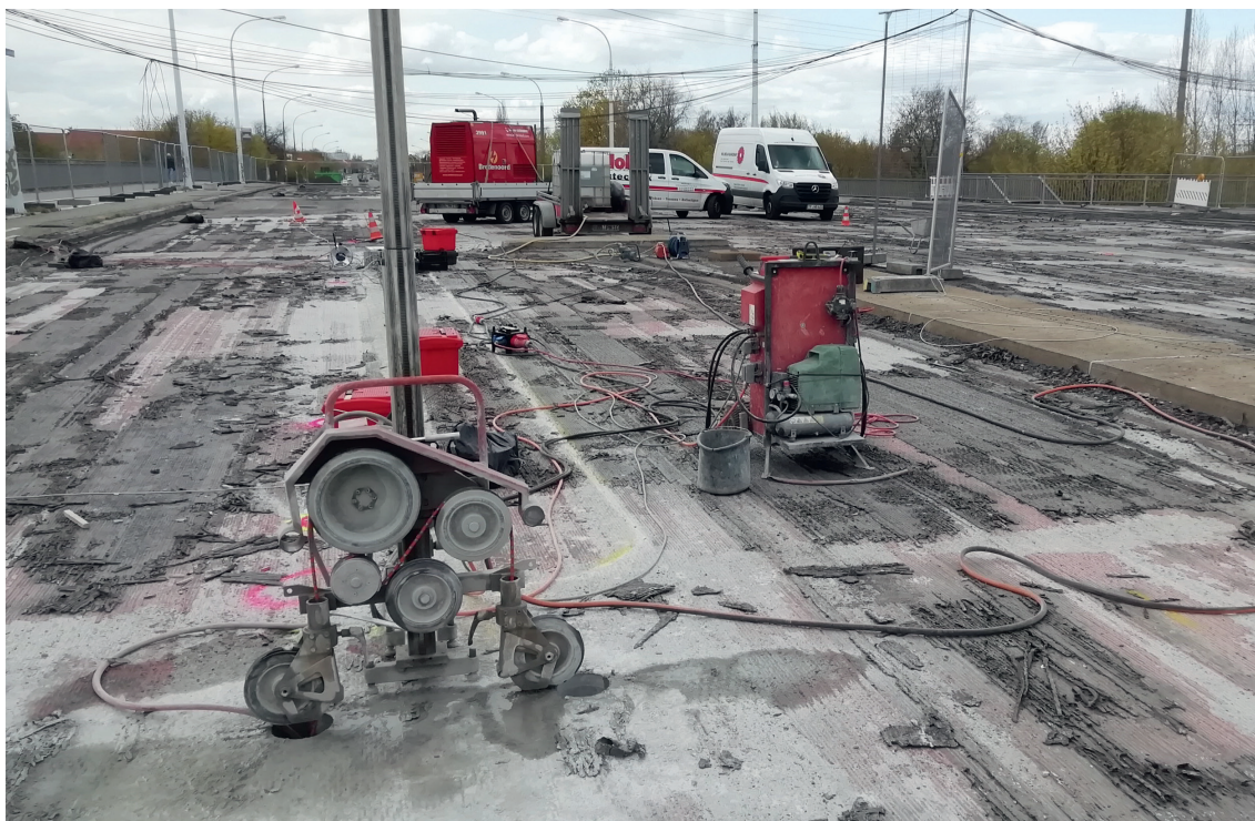
Abbildung 3.2c: Schnittstelle mit Seil auf Umlenkrolle, Ansicht auf der Fahrbahnplatte
