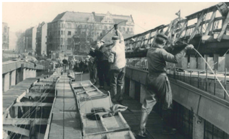
Abbildung 2.2c: Einlegen der Spanndrähte bei Bau der Eisenbrücke [Privatarchiv Fritz Niedergesäß, Berlin]
