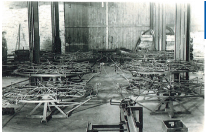
Abbildung 2.2b: Lagerplatz für die Spindeln der Spanndrähte, Brücke am Altstädter Bahnhof [Privatarchiv Richard Matthea, Brandenburg]
