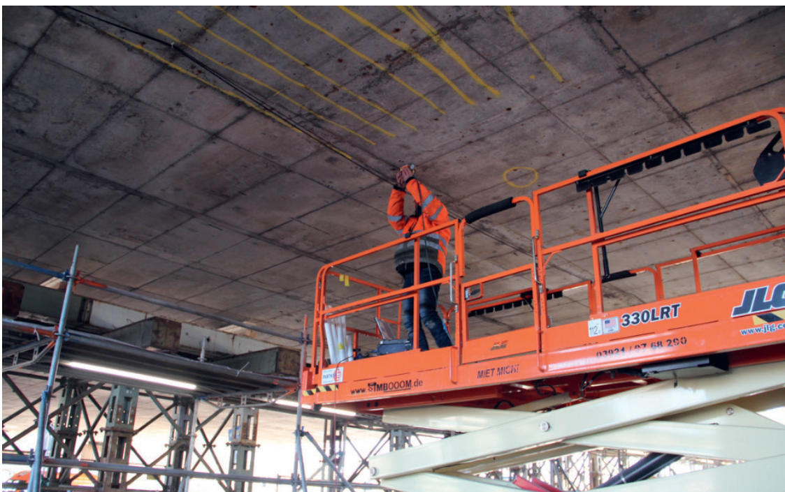
Abbildung 4.1b: Durchführung der Radarmessung von einem Hubsteiger
