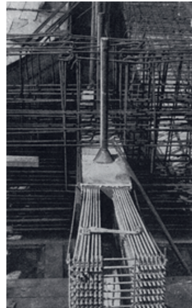
Abbildung 2.2e: Spannstahlfächer und bewehrter Spannblock [Bautechnik 1969]
