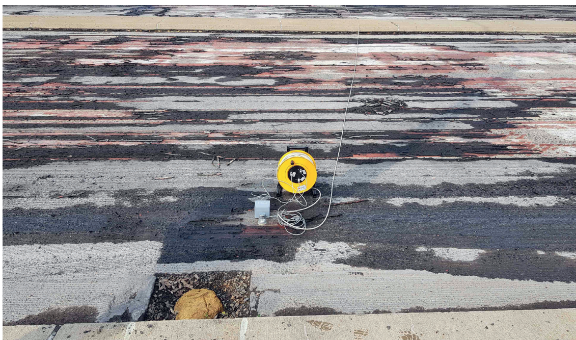
Abbildung 5.3c: Messstelle auf der Brücke mit einem MEMS-Sensor, einem Geophone und Kabeltrommel
