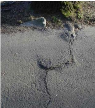
Beispiel: Zustandsmerkmal Einzelrisse und Risshäufung bei Asphaltbauweise
