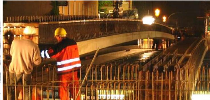
Einheben der Preflexträger in einer Nachtsperre
