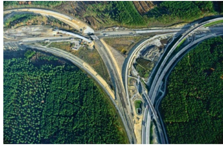
Das AD Havelland während des Umbaus (11/2013)
