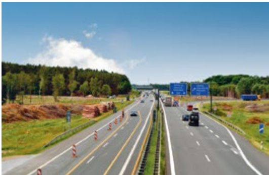
Rodungsarbeiten im Bereich des Autobahndreiecks
