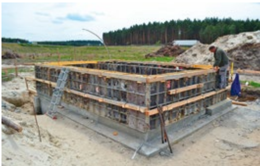
Bau des neuen Kabelhauses
