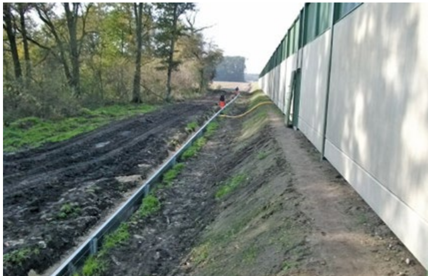
Sockel- und Wandelemente Fledermausüberflughilfen und Amphibienleitwand
