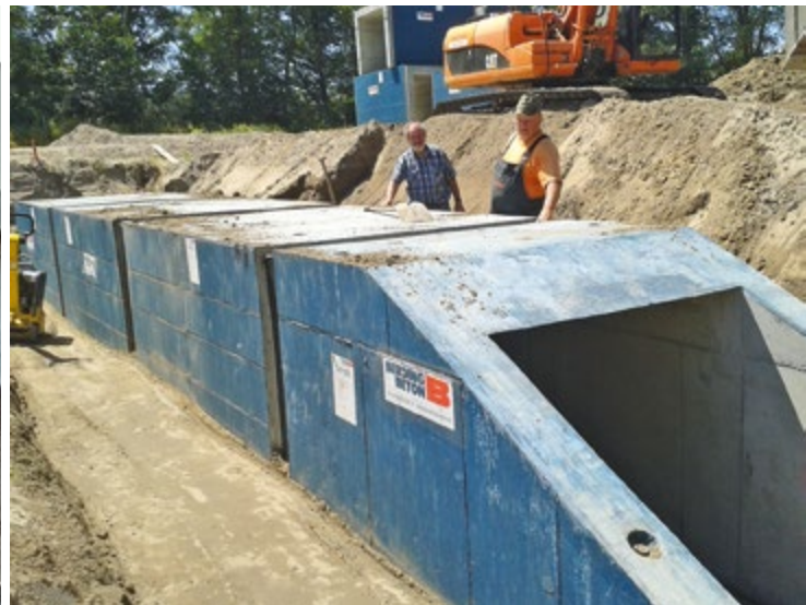
Einbau Durchlass
