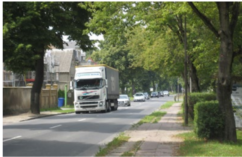
Vor dem Bau der Ortsumgehung: Ortsdurchfahrt Mahlow im Zuge der L 76
