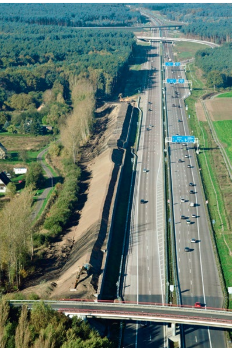
A 10 Nordring – Lärmschutzwall bei Wolfslake
