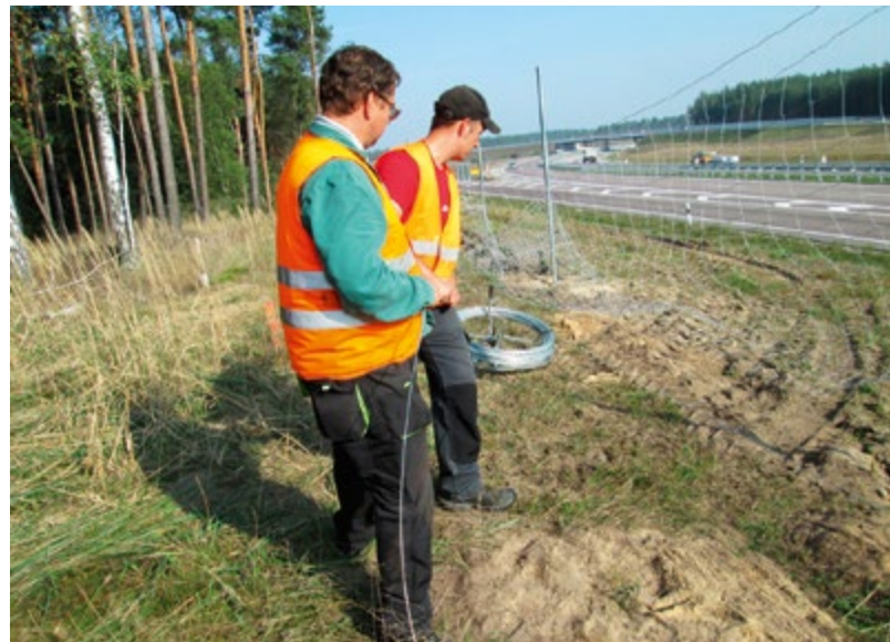
Errichten des Wildschutzzaunes
