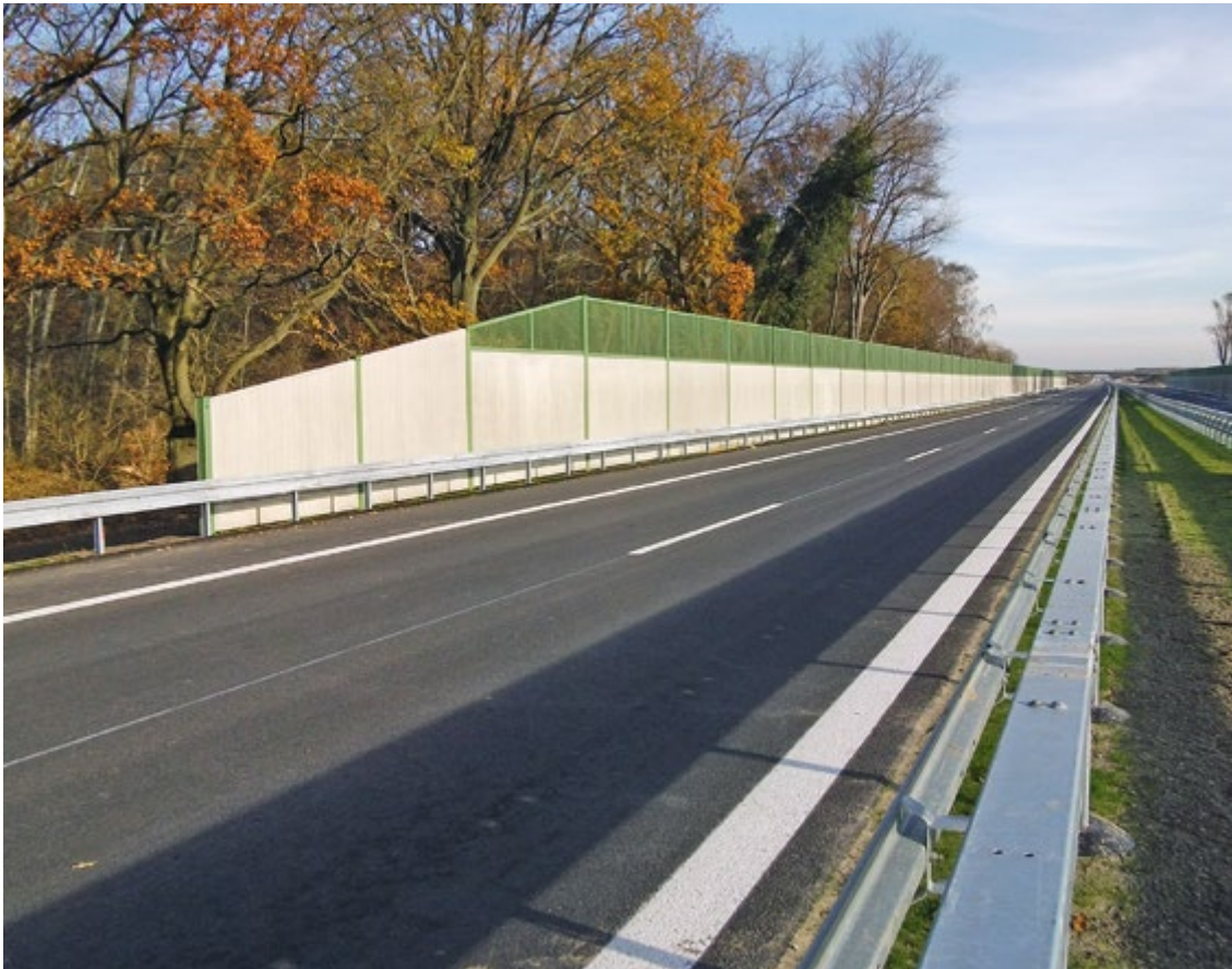
Fledermausüberflughilfen beidseitig der L 76 (neu)
