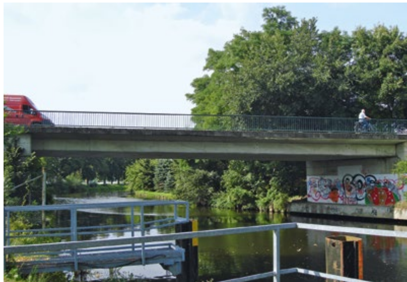
Bestandsbauwerk vor Baubeginn 2013
