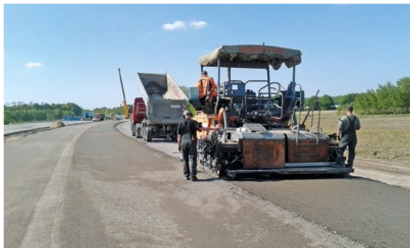
Einbau Verfestigung
