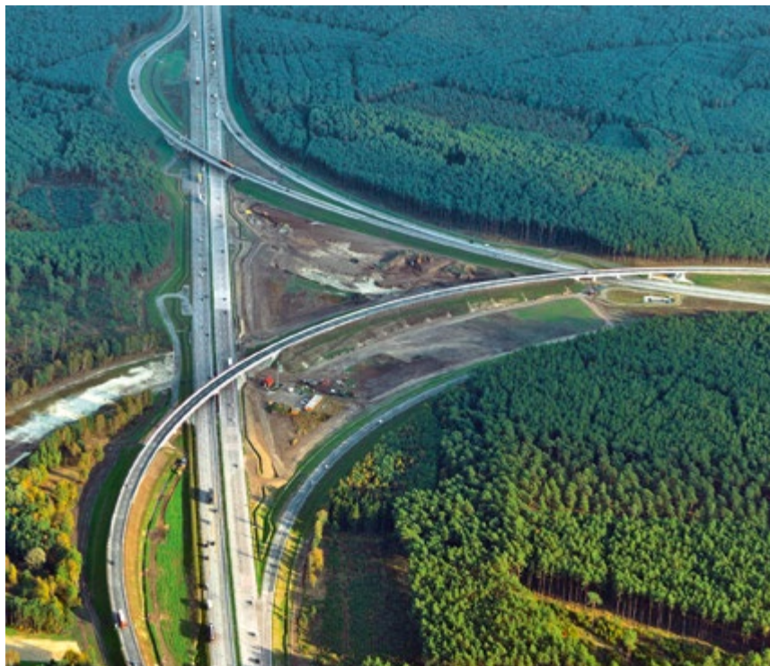
Blick auf das AD Havelland in Richtung A 10 Nordring (10/2014)
