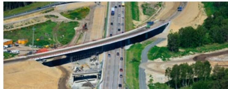
Abbruch des alten Kreuzungsbauwerkes und neues Kreuzungsbauwerk 0Ü0
