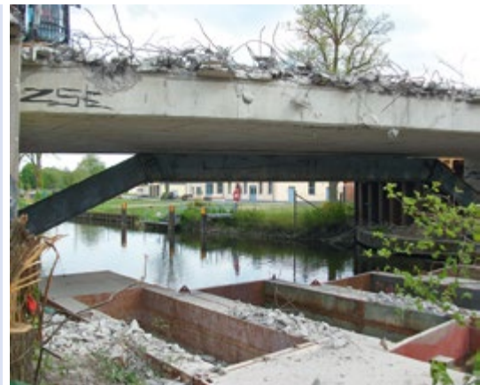
Abbruch des Bestandsbauwerkes
