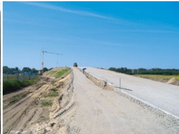
BW 6.1 – Überführung der Marienfelder Straße
