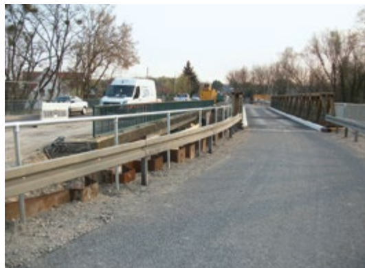
Behelfsumfahrung mit D-Brücke
