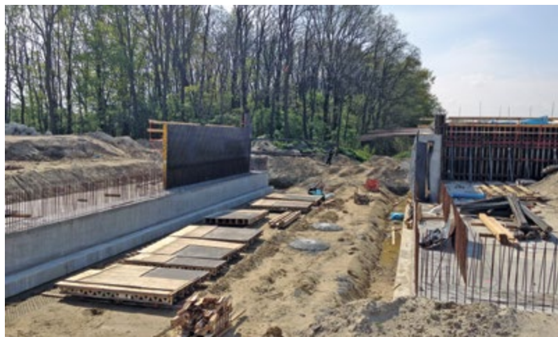
Schalung, Bewehrung BW 6
