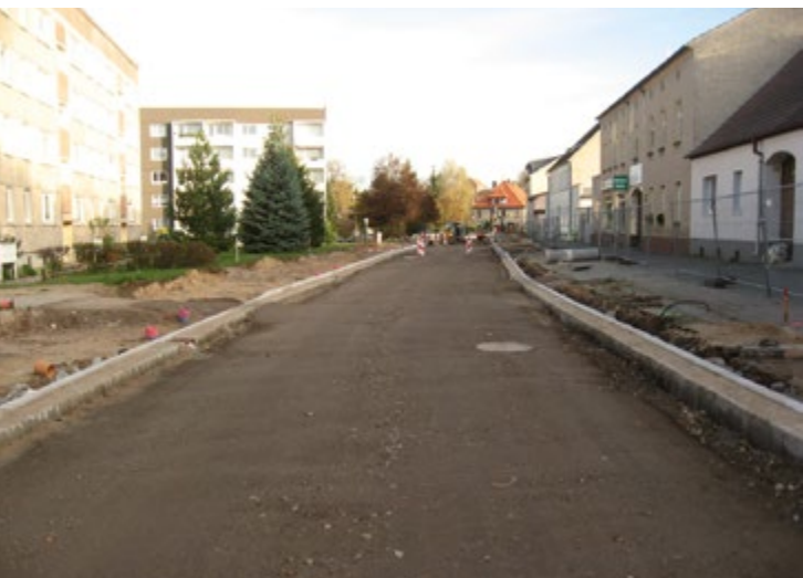
Ungebundene Tragschichten der Fahrbahn
