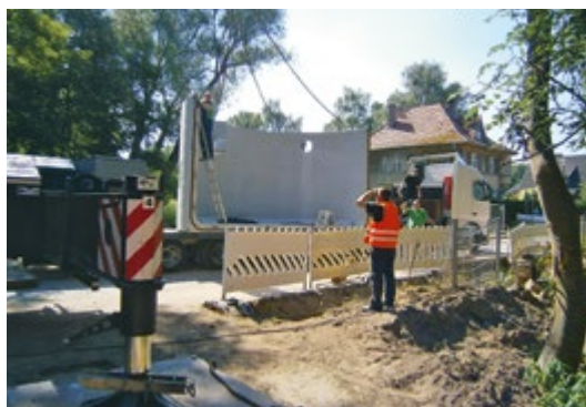
Einbau eines Fertigteils für eine SEDI-Anlage
