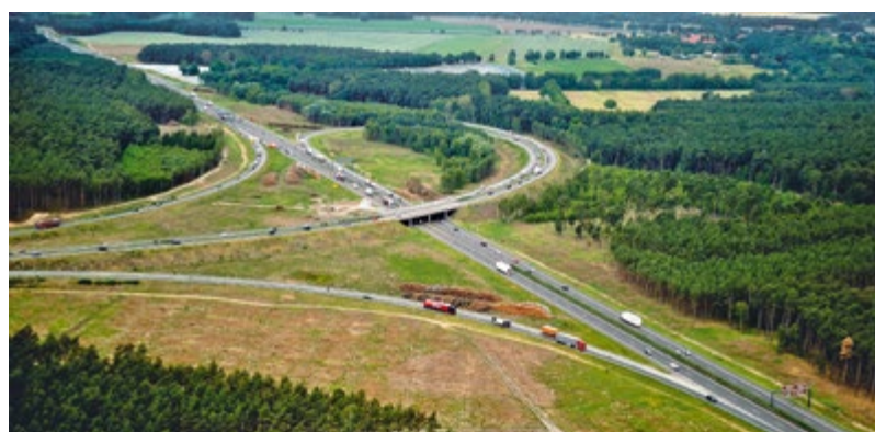
Das AD Havelland in Richtung A 24 vor dem Umbau (2012)
