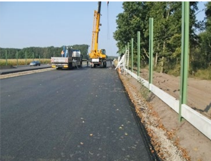
Bau Fledermausüberflughilfen
