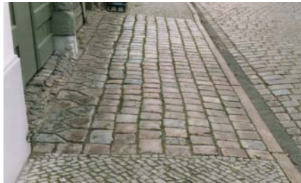
Großpflaster mit Bischofsmützen-Rand an Grundstückszufahrten (Nauen).
