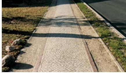
Pflasterstreifen im unbefestigten Seitenraum: Sparsame, landestypische Art der Befestigung (Güterfelde L 40/77).
