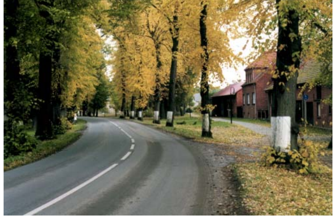
In landschaftlich geprägten Ortsdurchfahrten sollte die Fahrbahn ohne Separationselemente in die Seitenräume übergehen (Cumlosen B 195). Borde sind in derartigen Situationen völlig unangebracht.
