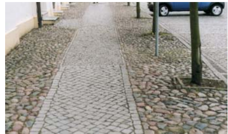
Gehweg in Mosaik und Kleinsteinpflaster zwischen Lesesteinen (Wusterhausen).
