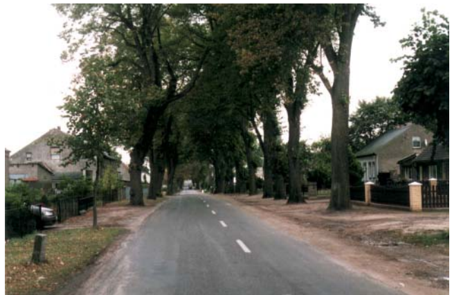
Für den örtlichen Straßenraum ist typisch, dass Fahrbahn und Seitenräume ineinander übergehen. Borde sind hier nur an den Bushaltestellen eingebaut (Hammelspring L 21).
