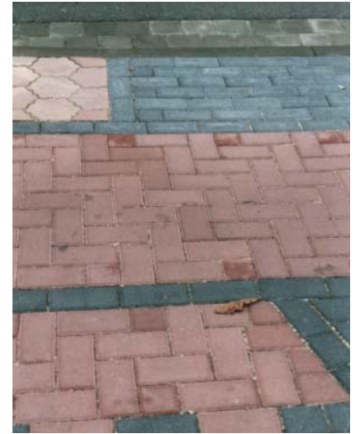
Eine Vielzahl verschiedener Formen und Farben garantiert noch keine gute Gestaltung. Natursteinflächen in Kombination mit Asphalt sind nicht teurer, aber wesentlich schöner. Asphalt sollte allerdings nur dort eingebaut werden, wo in absehbarer Zeit keine Aufbrüche (z. B. für Leitungsverlegungen) zu erwarten sind.
