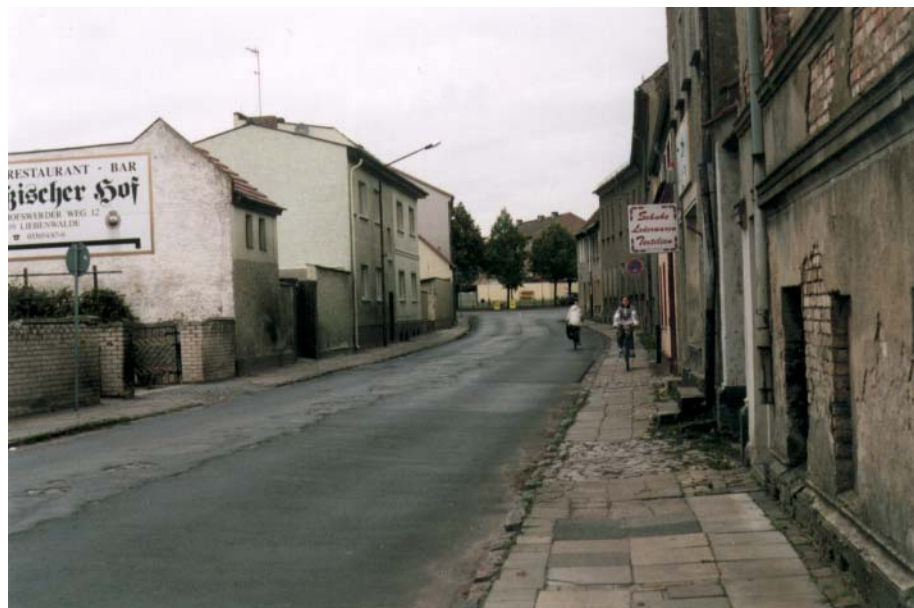
Manche Ortsdurchfahrten sind reine Verkehrsräume, Fußgänger und Radfahrer müssen sich schmale Streifen teilen. Der Raum ist unattraktiv und unsicher (Liebenwalde, B 167).
