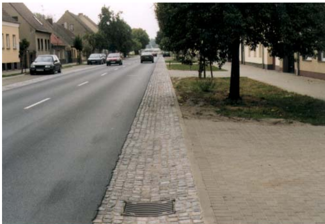
Gepflasterte Muldenrinnen dienen der Entwässerung und machen zugleich die Fahrbahn optisch schmaler (Kloster Zinna B 101). Sie sind ein gutes Mittel zur weichen Integration der Fahrbahn in den Raum.
