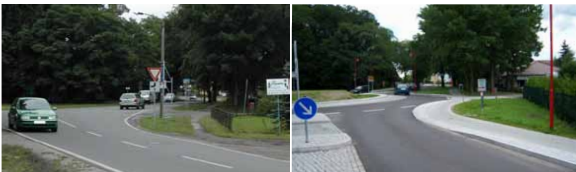
Bild 51: Kreuzung zweier Hauptverkehrsstraßen vor und nach dem Umbau (Beelitz)
