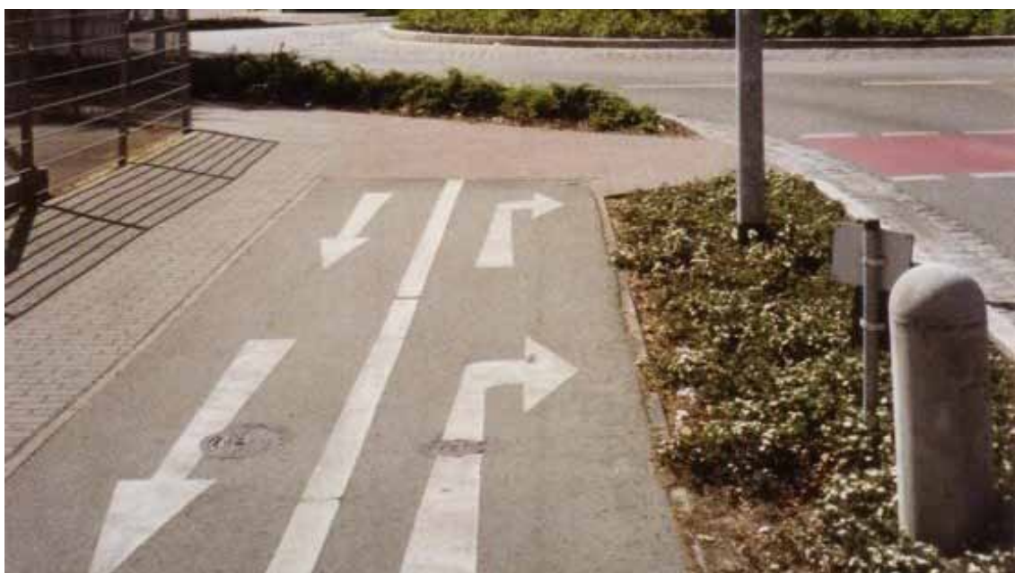
Bild 59: Markierung der Radwegeinführung in einen Kreisverkehr (Rathenow, Semliner Straße)
