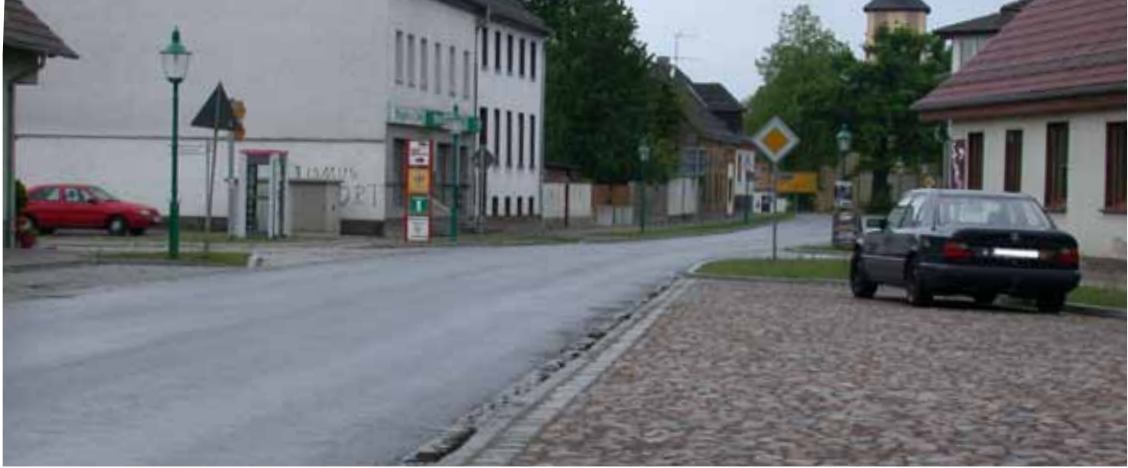
Bild 78: Großflächige Verwendung von Lesesteinpflaster auf „Multifunktionsflächen“ (Märkisch-Buchholz)
