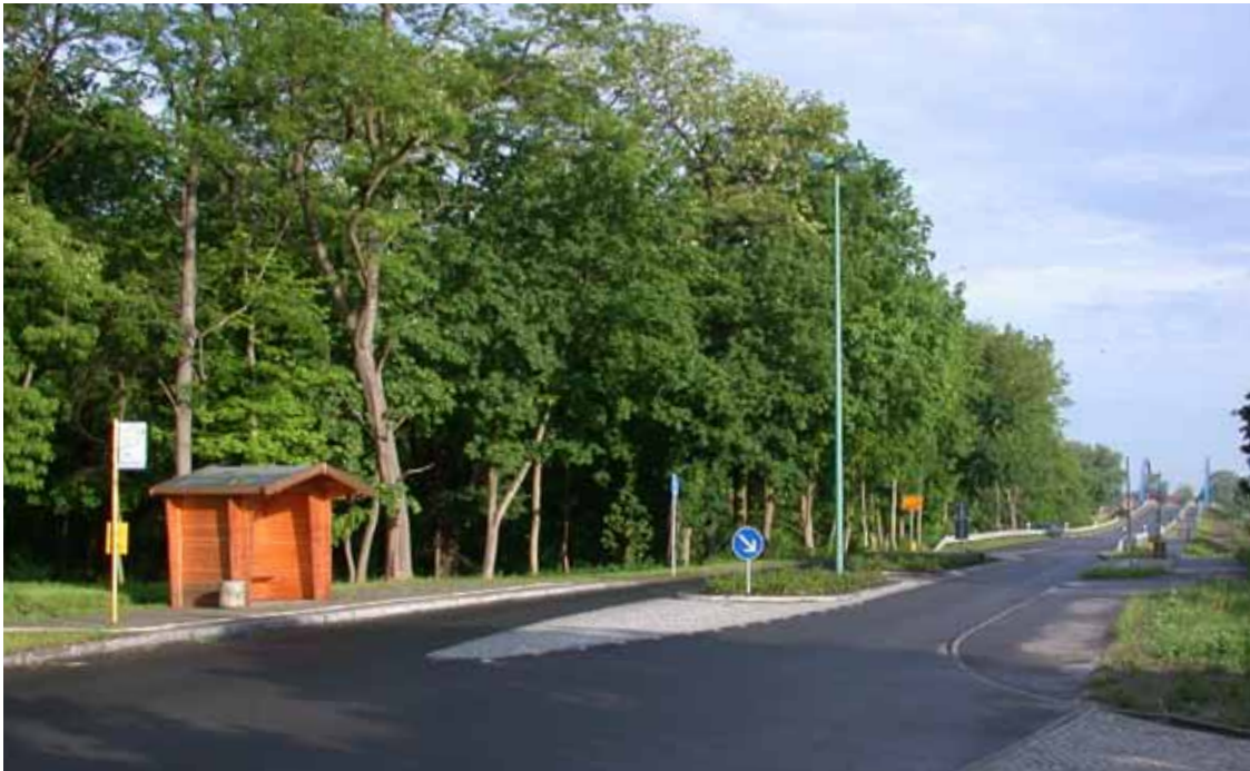
Bild 67: Bushaltestellen an Mittelinsel (Paaren) – die Straßenbeleuchtung auf der Insel ist nicht die Regellösung
