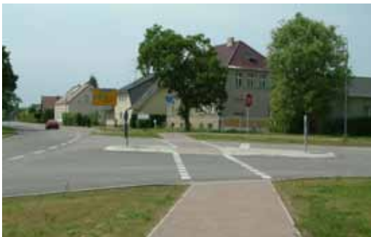
Bild 52: Einmündung mit abgesetzter Radwegführung (Herzberg)
