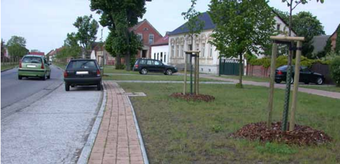
Bild 63: Gepflasterter Weg neben Grünflächen zwischen Parkständen und Gehweg (Neustadt/ Dosse)
