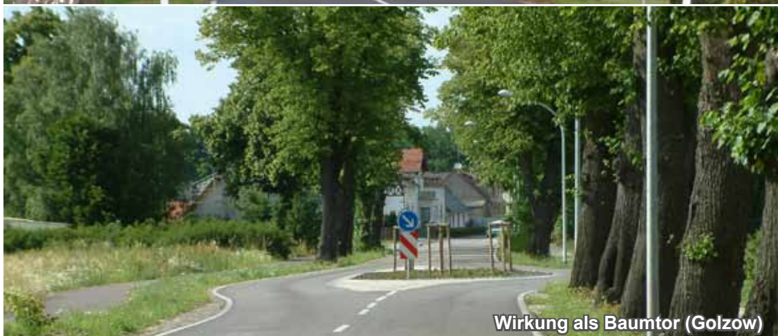
Bild 42: Verstärkung der geschwindigkeitsdämpfenden Wirkung von Mittelinseln durch Raumbildung
