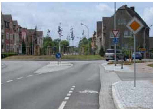
Bild 81: Kreisverkehr mit sparsamer Beschilderung (Treuenbrietzen)
