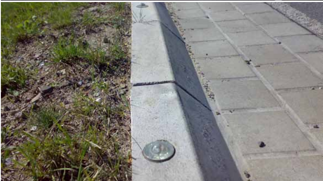
Bild 79: Verdeutlichung der Fahrbahnführung durch Glasmarker
