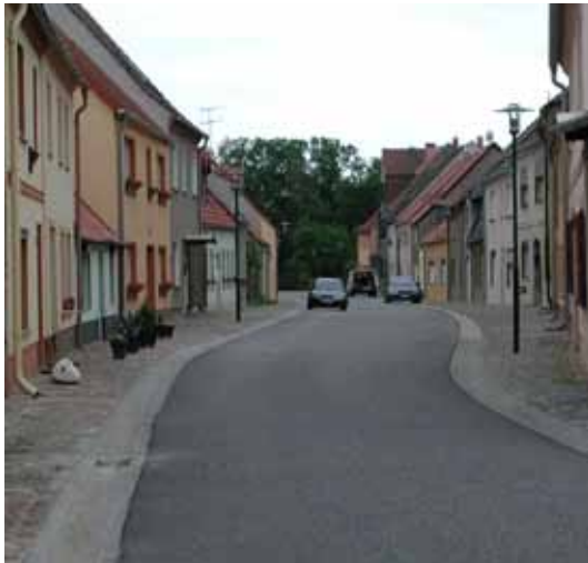
Bild 31: Seitenraum in enger Ortsdurchfahrt in Luckau
