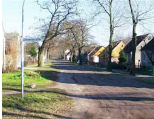
Bild 43: Straße vor dem Ausbau (Wustrau)
