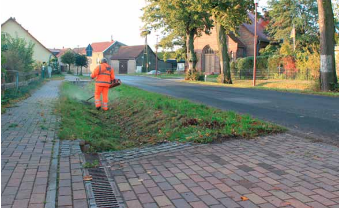
Bild 42: Pflege der Entwässerungsanlagen
