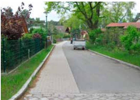
Bild 46: Ausgebaute Wohnstraße (Birkenwerder)
