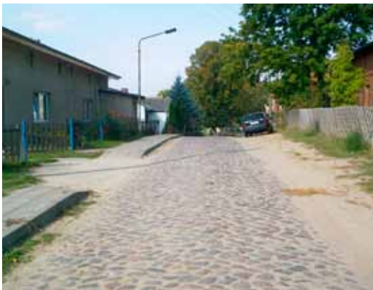
Bild 2: Wohnstraße mit Pflasterbefestigung vor dem Ausbau
