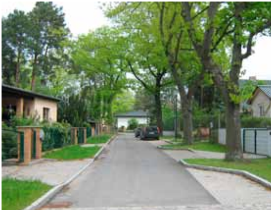
Bild 10: Stellplätze längs am Fahrbahnrand (Birkenwerder)
