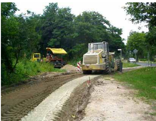
Bild 20: Durchführung der Verfestigung im Mixed-in-place-Verfahren
