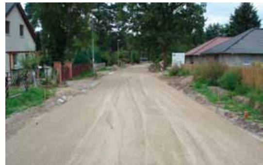
Bild 29: Herstellung einer Verfestigung (Schöneiche)
