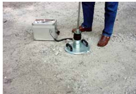
Bild 17: Tragfähigkeitsmessung mit dem Leichten Fallgewichtsgerät in einem Schlagloch der alten sandgeschlämmten Schotterdeckschicht nach der Verfüllung mit standfestem RC-Material ( E_{vd} = 120\text{ MN/m}^2 )
