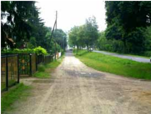
Bild 18: Vorhandene ungebundene Straßenbefestigung vor der Verfestigung
