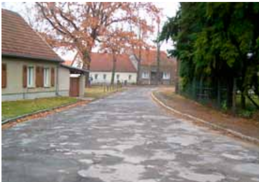
Bild 5: Wohnstraße mit alter Asphaltbefestigung
