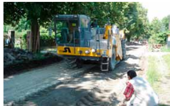
Bild 30: Herstellung einer Zementverfestigung (Neuenhagen)
