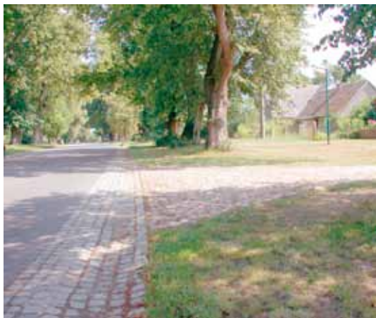
Bild 22: Separation ländliche Ortsdurchfahrt
