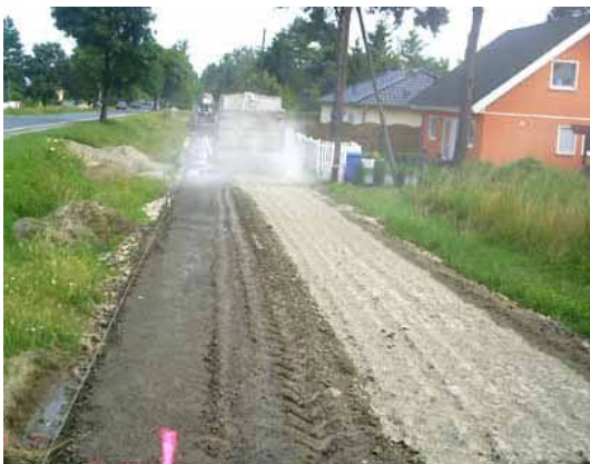
Bild 19: Bindemittelverteilung für die Verfestigung
