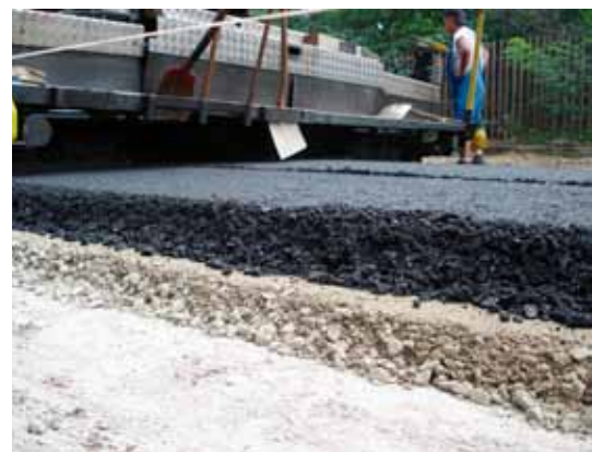
Bild 23: 8 cm dicke ungebundene Zwischen-schicht 0/22
