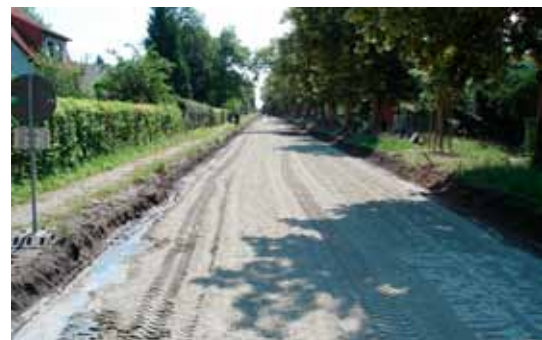
Bild 31: Herstellung einer Zementverfestigung (Neuenhagen)
