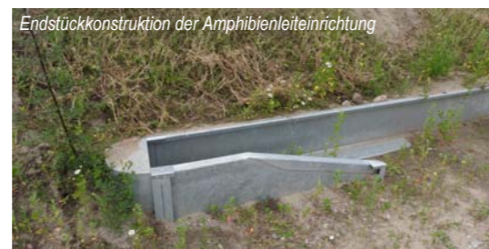
Endstückkonstruktion der Amphibienleiteinrichtung
