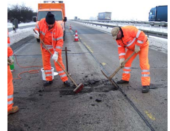
A 11 Reichsautobahn – grundlegende Rekonstruktion
