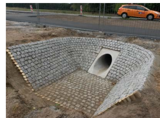
Durchlass fertiggestellt, Umpflasterung mit Natursteinpflaster
