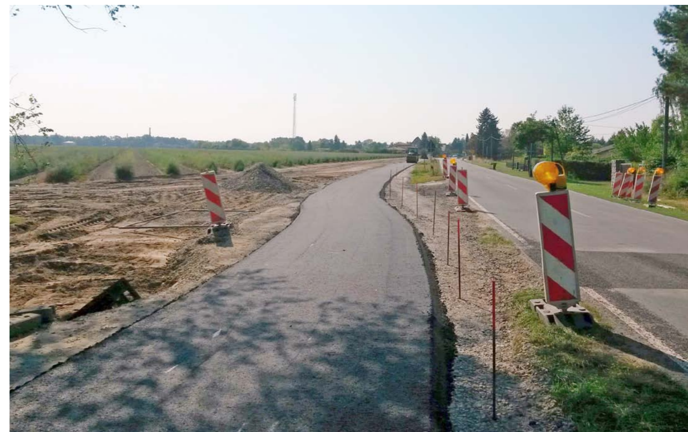
Radweg Landesstraße 911 Brandenburg a.d.H – Teilabschnitt 2
