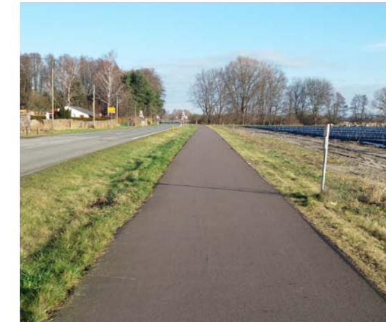
fertiger Radweg entlang der L 911
