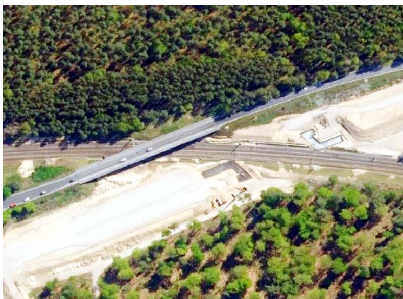
Abb. 14: Luftbild während des Baus
