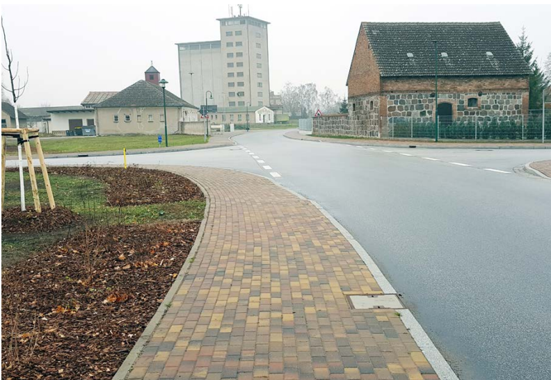
Abb. 18 : nach dem Ausbau
