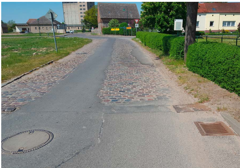
Abb. 17: vor dem Ausbau
