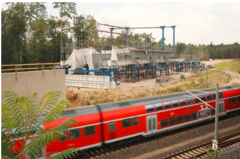
Abb. 6: Beginn der neuen Dammaufschüttung westlich neben dem bestehenden Bauwerk
