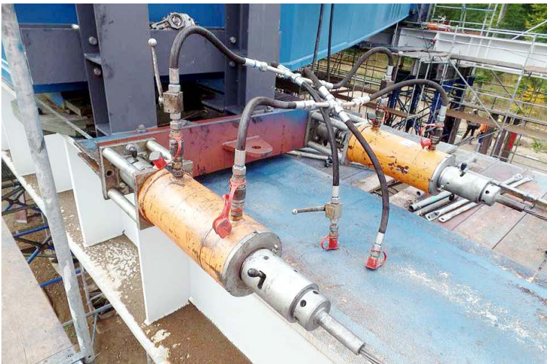
Abb. 8: Vortrieb des Stahlüberbaues durch Litzenheber
