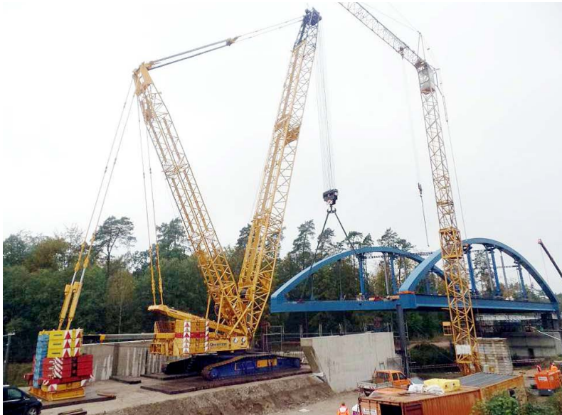
Abb. 10: Der Raupenkran hinter Widerlager Achse 20 übernahm nach circa 26 m freien Verschiebung den Überbau und setzte ihn in seine Sollage.
