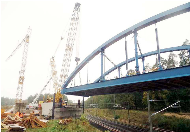
Abb. 11: Während des Verschiebens
