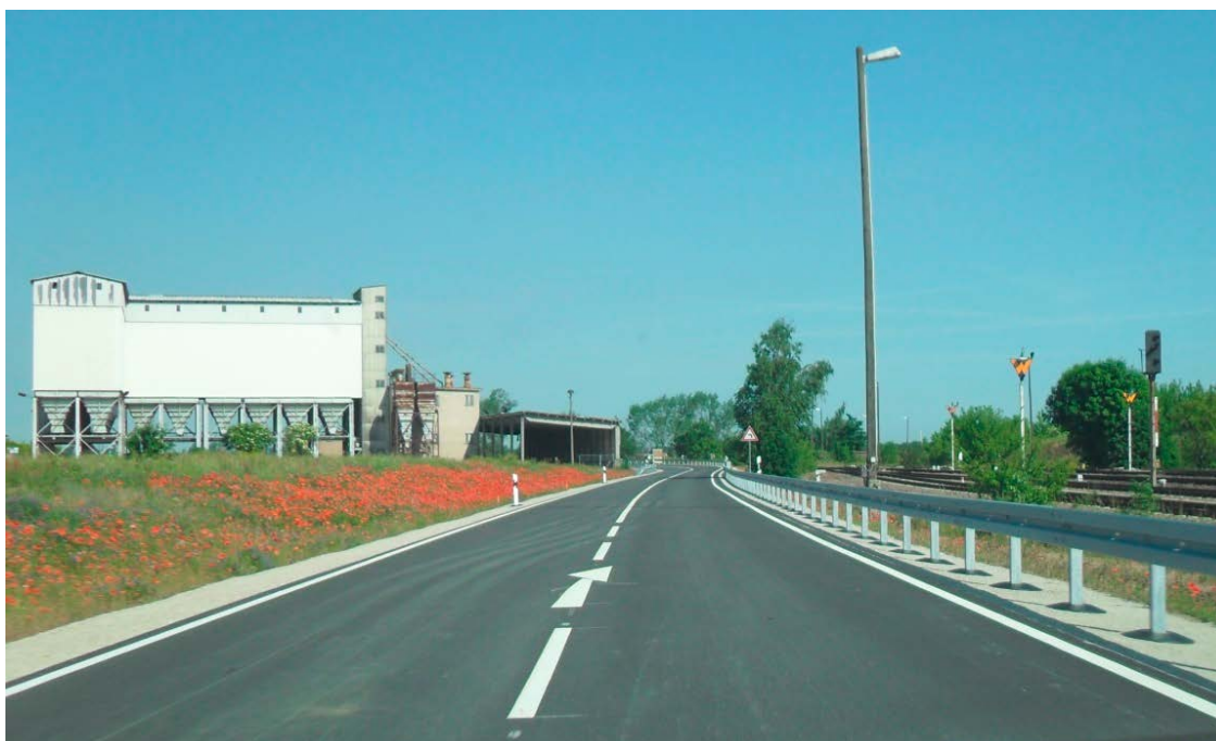
Abb. 25: Abschnitt der L 67 nach Fertigstellung
