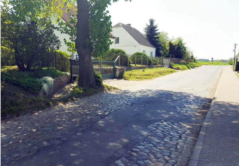
Abb. 21: vor dem Ausbau
