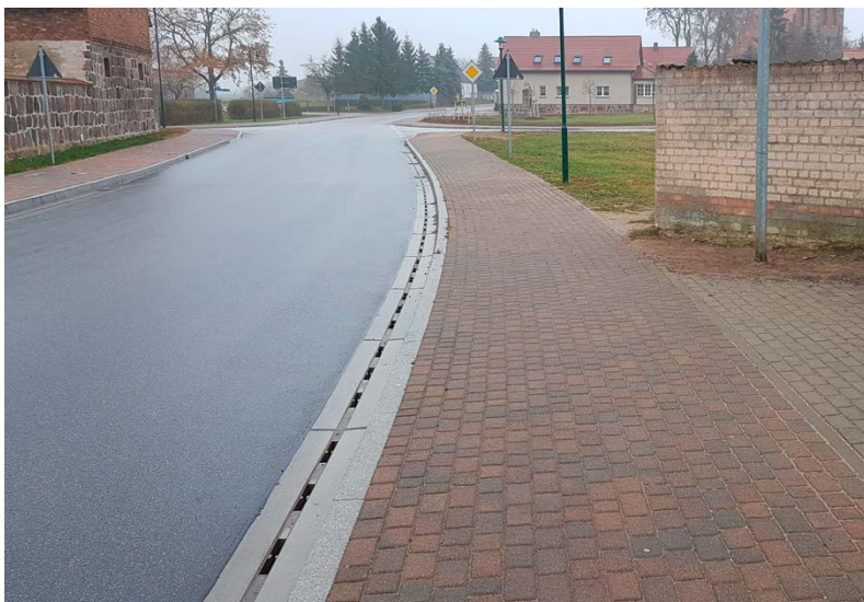
Abb. 20: nach dem Ausbau
