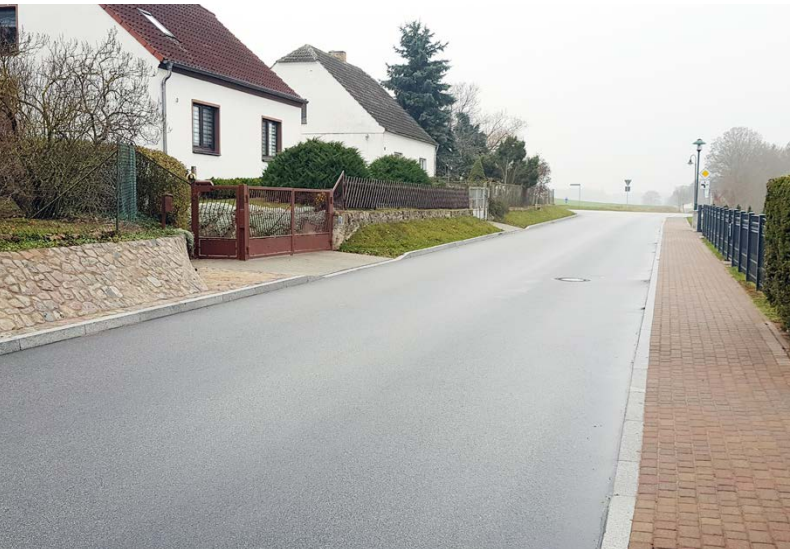
Abb. 22: nach dem Ausbau
