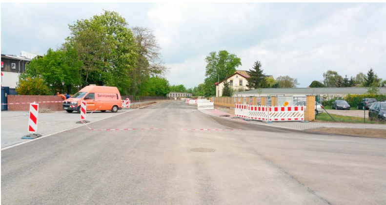
Abb. 24-27: L 172 Ortsdurchfahrt während des Baus
