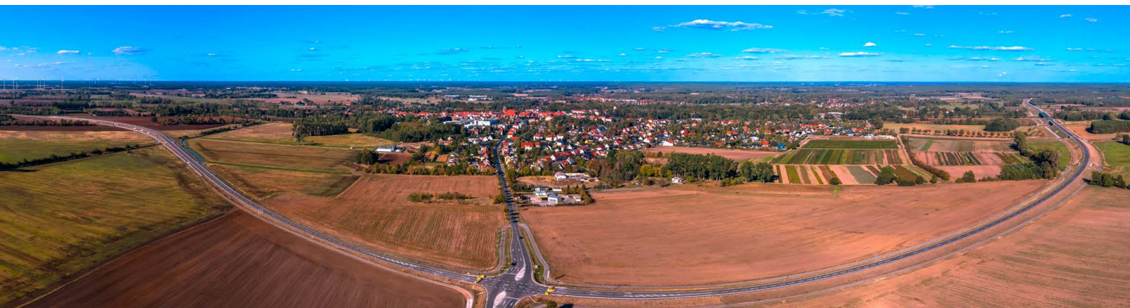
Abb. 14: Luftbild Ortsumgehung nach Fertigstellung
