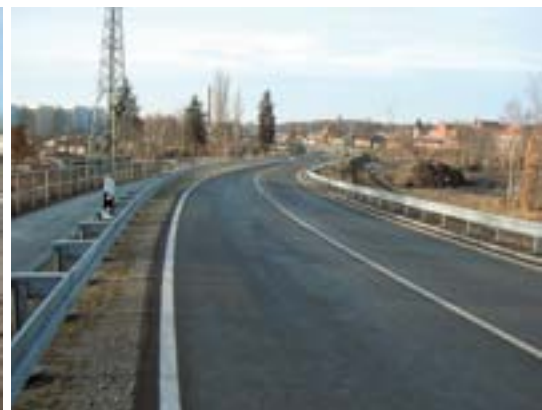
Trassenverlauf im Los 3.1.1, Rückblick vom Bauwerk 8-1
