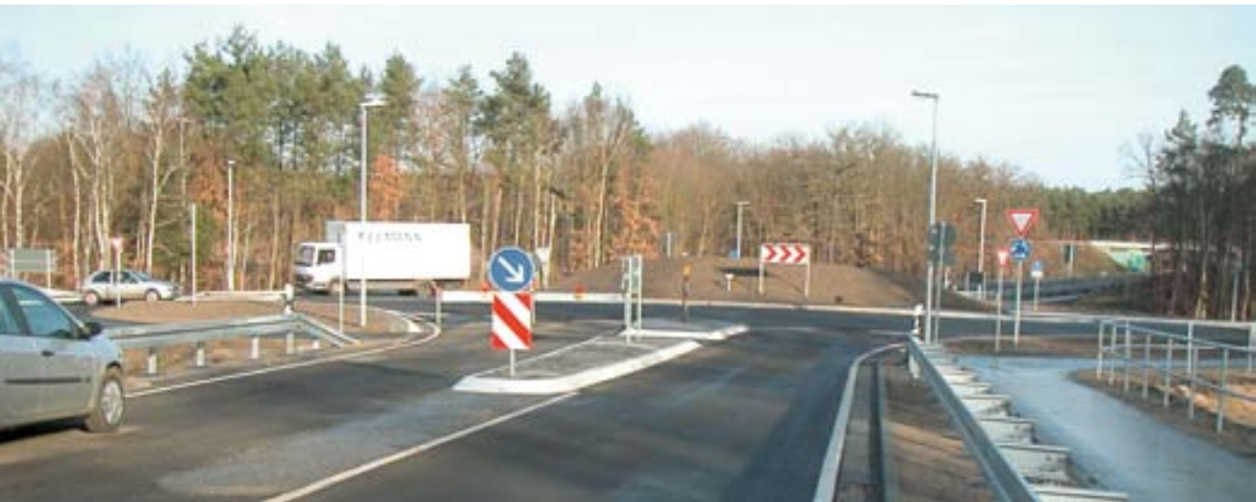
Kreisverkehr Knotenpunkt 5, Vorblick vom Bauwerk 8-2
