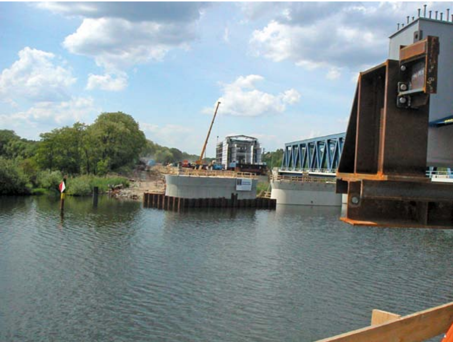
BW 5-1 im Bau
