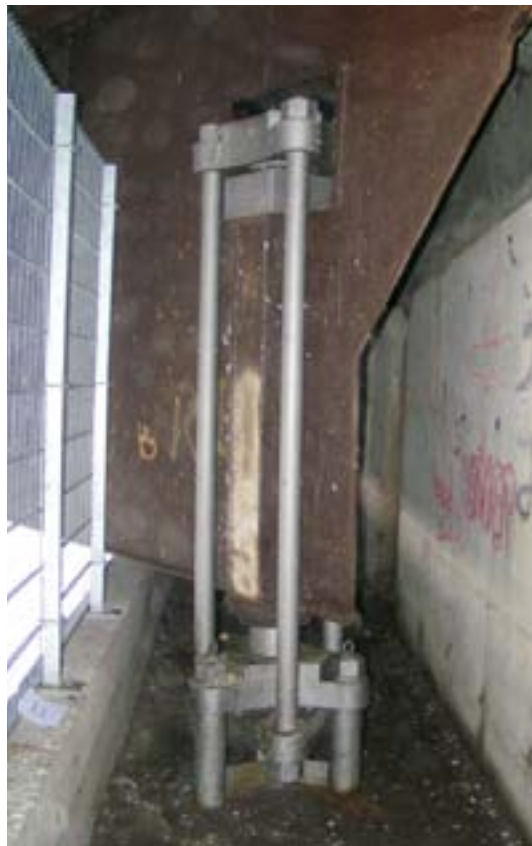
Zug-/Druck-Sonderlager des ehemaligen Bestandes
