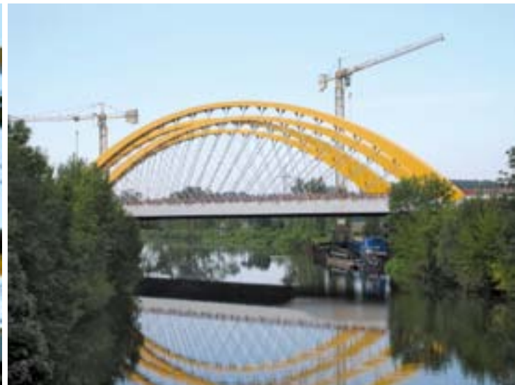
Ansicht Neubau von Osten
