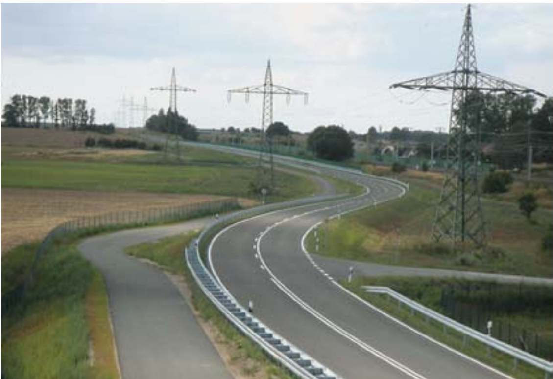
Unterführung der 110-kV-Bahnstromleitung
