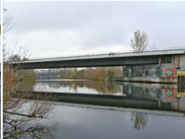
Ansicht ehem. Bestand von Westen
