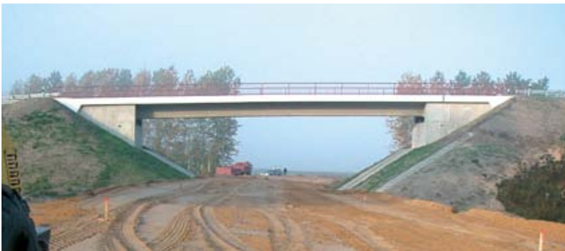
BW 2-1, Überführung eines Wirtschaftsweges
