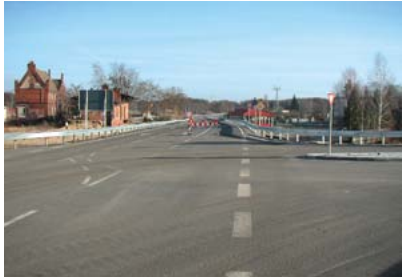
KP 4, nach dem Ausbau
