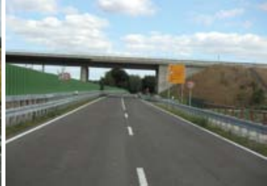
BW 3-1, Überführung der L 96, Abfangen der Böschung einschließlich Herstellung der Berme
