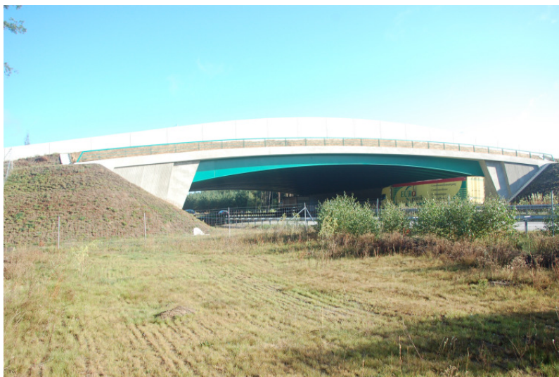
Abb. 2: Grünbrücke über die BAB 13 bei Teupitz
