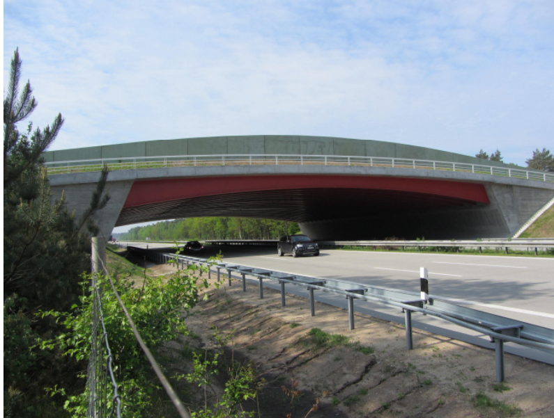
Abb. 1: Grünbrücke über BAB 9 bei Niemegek
