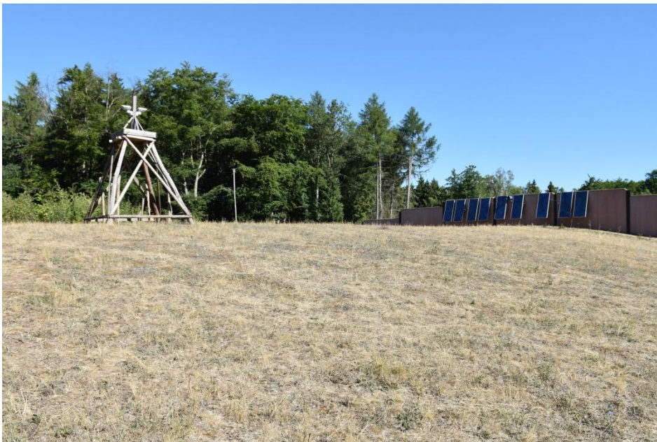
Abb. 79: Blick auf die Grünbrücke Anfang Juni 2018
