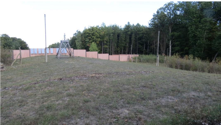
Abb. 81: Blick auf den Brückenscheitel (27. September 2018)
