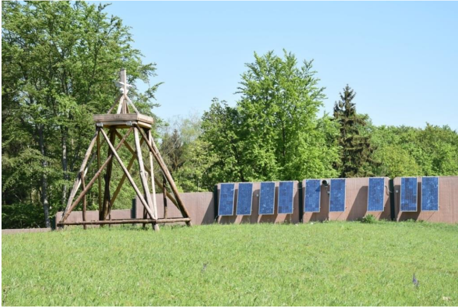
Abb.1: Videoüberwachungsanlage auf der Grünbrücke Melzower Forst
