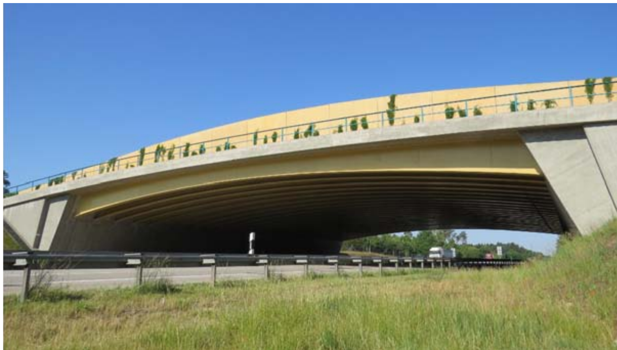
Abb. 71: Grünbrücke über die BAB 12 bei Kersdorf
