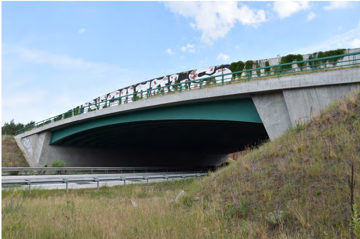
Abb. 44: Grünbrücke über die BAB 13 bei Teupitz
