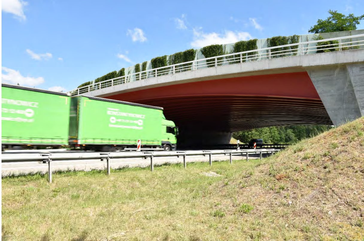
Abb. 1: Grünbrücke über die BAB 9 bei Niemegk
