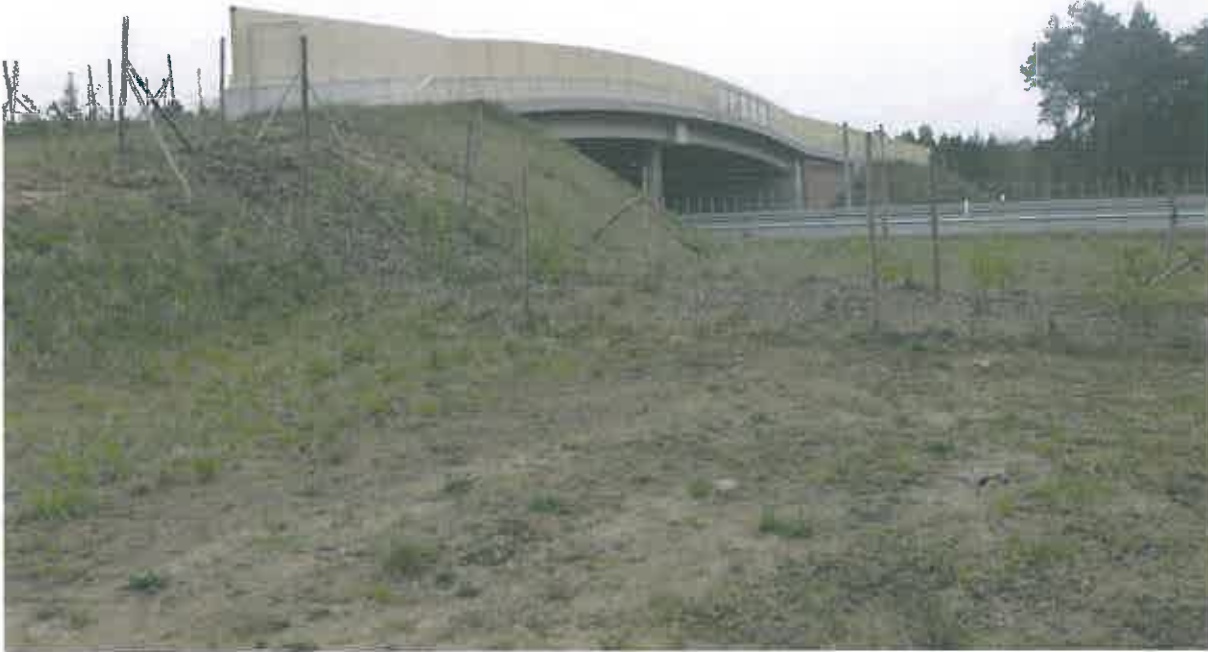
Abbildung 17: Pflanzungen, die auf die Grünbrücke führen, sind noch zu kleinwüchsig (Foto: M. Krowiorz)
