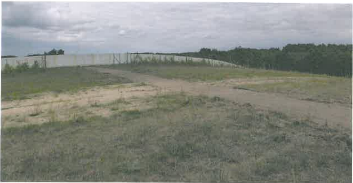
Abbildung 16: Sträucher und Gehölze auf der Grünbrücke mit noch zu geringer Höhe und Dichte für eine Leitstrukturfunktion (Foto: M. Krowiorz)
