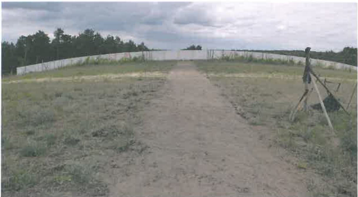
Abbildung 2: Kontrollstreifen mittig der Grünbrücke
