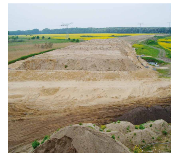
Bild 3: Dammschüttung mit Überschüttung
