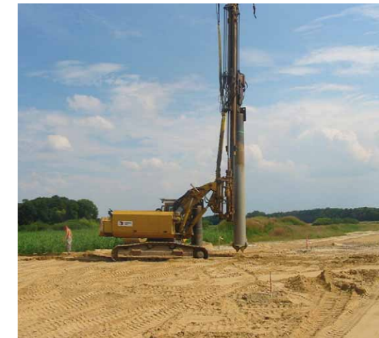
Bild 2: Herstellung der Sandsäulen
