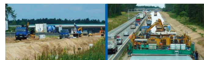
links: Erdbauarbeiten; rechts: Betonfertiger-Einsatz
