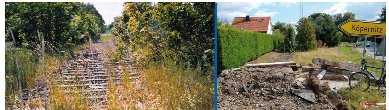
links: Ansicht beim Baubeginn; rechts: Bauanfang bei Köpernitz
