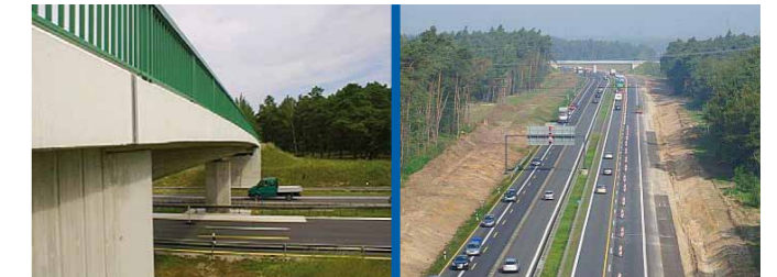
links: Bereits im Vorfeld des grundhaften Ausbaus ist der Bau der Überführung eines Wirtschaftsweges realisiert worden; rechts: Blick auf die A 13 zu Beginn der Bauphase 1
