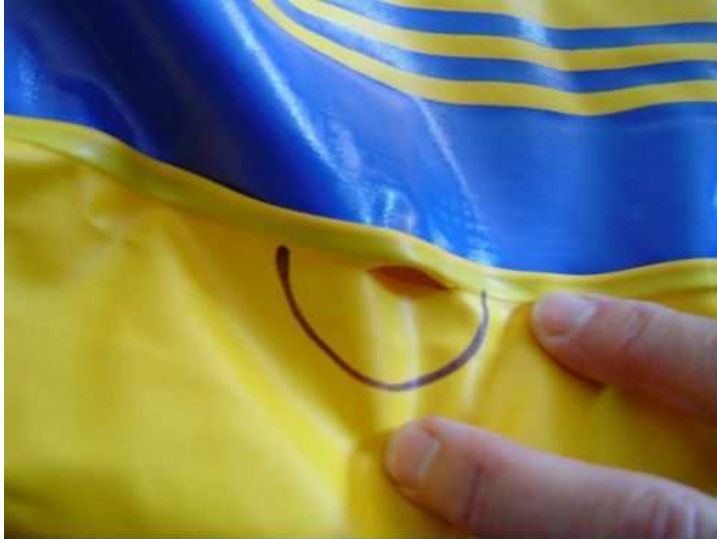
Bild: Riss der Schweißnaht an der Hauptkammer
