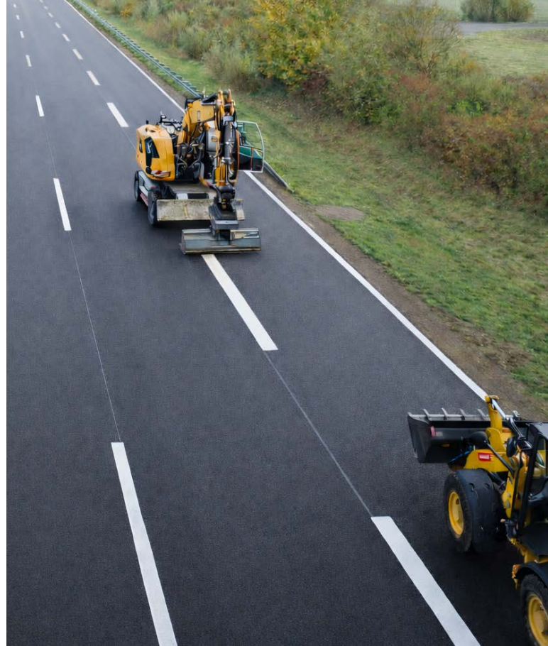
Abb. 2: Die erneuerte Fahrbahn entlang der Erprobungsstrecke auf der B 5, Foto: LS
