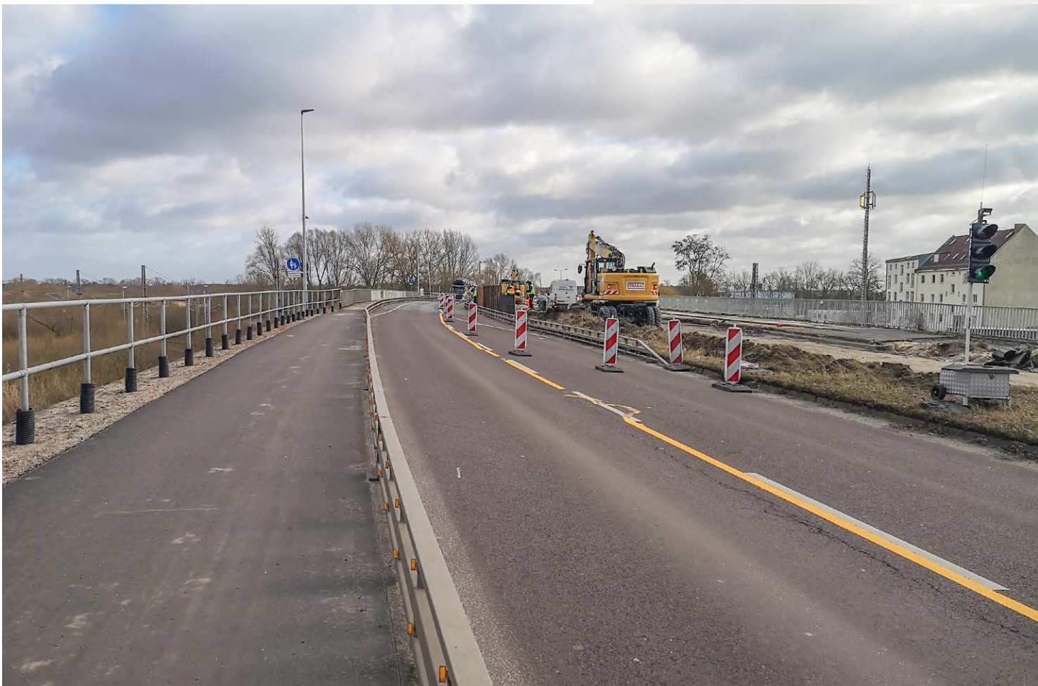
Abb. 4: Die Brücke entlang der Potsdamer Straße in Brandenburg an der Havel während der einseitigen Verkehrsführung und gleichzeitig durchgeführten Sanierungsarbeiten, Foto: LS
