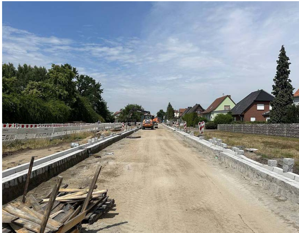
Abb. 5: Die L 13 nach der Beseitigung der alten Fahrbahndecke, Foto: LS
