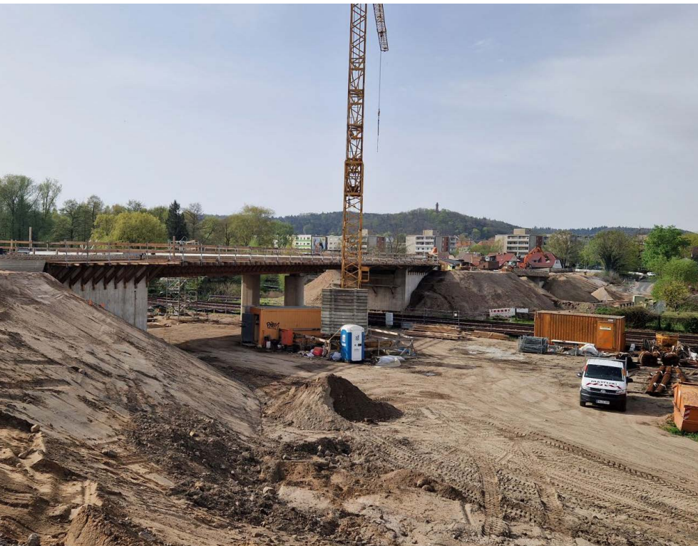
Abb. 3: B 158, Dammbauwerk in Bad Freienwalde während der Instandsetzungsarbeiten, Foto: LS
