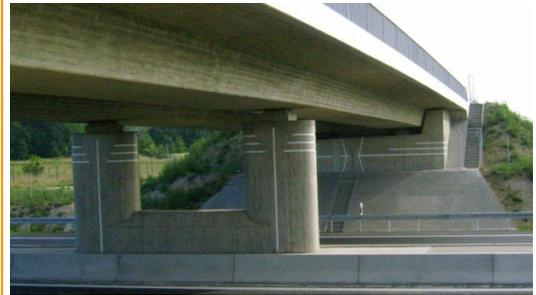
In Pfeilern und Widerlagern angeordnete Streifen als Vertiefung können nachträglich farblich abgesetzt oder durch bereits vor dem Betonieren eingelegte Edelstahlbänder erreicht werden. Sie erzeugen zusammen mit der natürlichen Sichtbeton-Struktur aus der Holz-Brettschalung eine moderne Eleganz.
