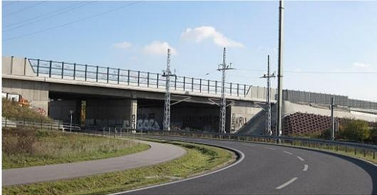
Ansicht BW 11 mit Bewehrter Erde Konstruktion aus BW 10
