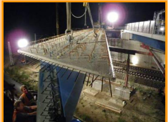
Verbundträgermontage Bauwerk 73 in nächtlicher Sperrpause der Bahntrasse
