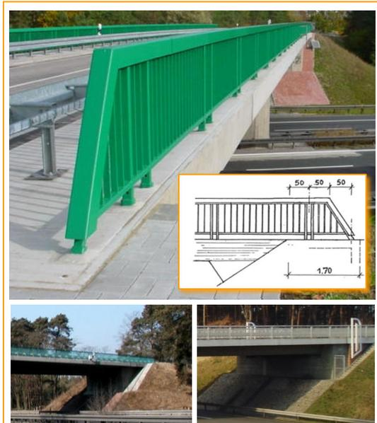
Besonders bei Überführungsbauwerken nehmen Fahrer und Beifahrer die Gestaltung und Farbgebung wahr, zumal bei diesen Konstruktionen Füllstabgeländer mit dichterem Anordnung der Stäbe zu verwenden sind. Bei dem oben dargestellten Beispiel wurde das Geländer am Brückenkende schräg abgesenkt und je nach Autobahn verschieden eingefärbt:
