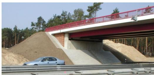
Mit bei kleinen Flächen vorgesehenen Klinker-mauerwerk-Verblendungen und passender Farbgebung bei den Stahlverbund-Hauptträgern und Geländern lässt sich eine kostengünstige Gestaltung erzielen. In diesem Fall sollte die Böschungsbefestigung vor dem Widerlager unauffällig ausgebildet werden.
