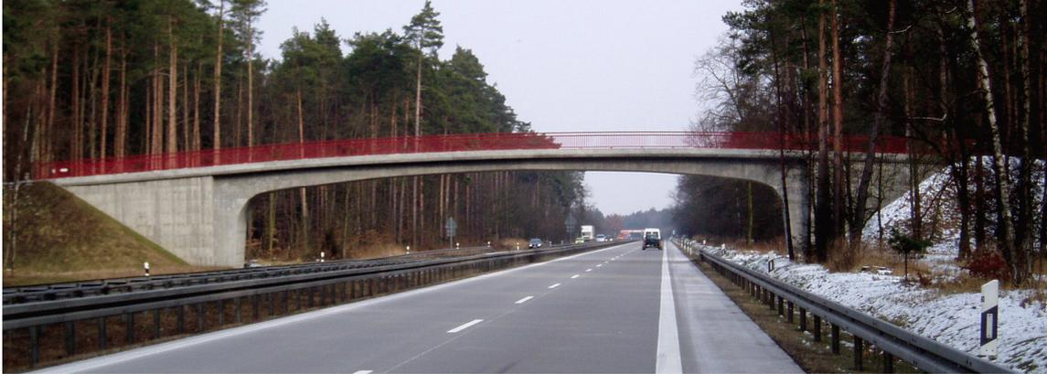
Bauwerk 10Ü1 – A11 typische Wirtschaftswegebrücke als Zweigelenkrahmen aus Stahlbeton
