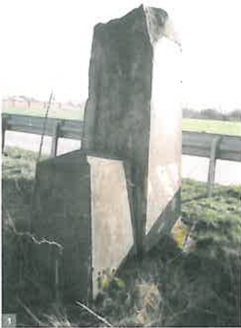
1 Ganzmeilenstein Kletzke vor der Restaurierung
