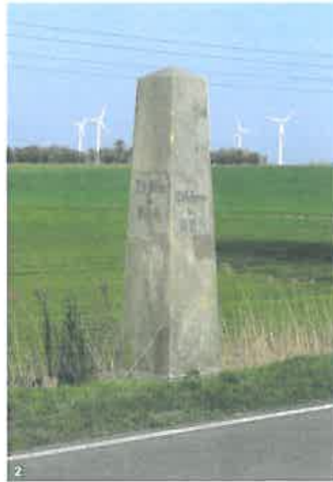
2 Ganzmeilenstein Kletzke nach der Restaurierung
