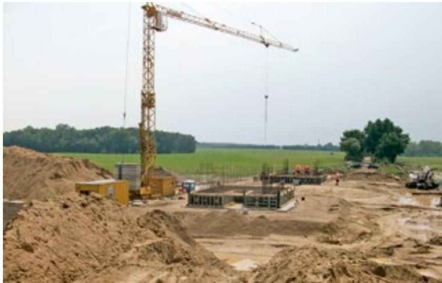
Schalungs- und Bewehrungsarbeiten am Widerlager einer Brücke
