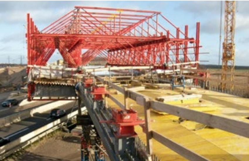
Herstellung der Fahrbahnplatte am BW 90Ü3 mithilfe des Schalwagens
