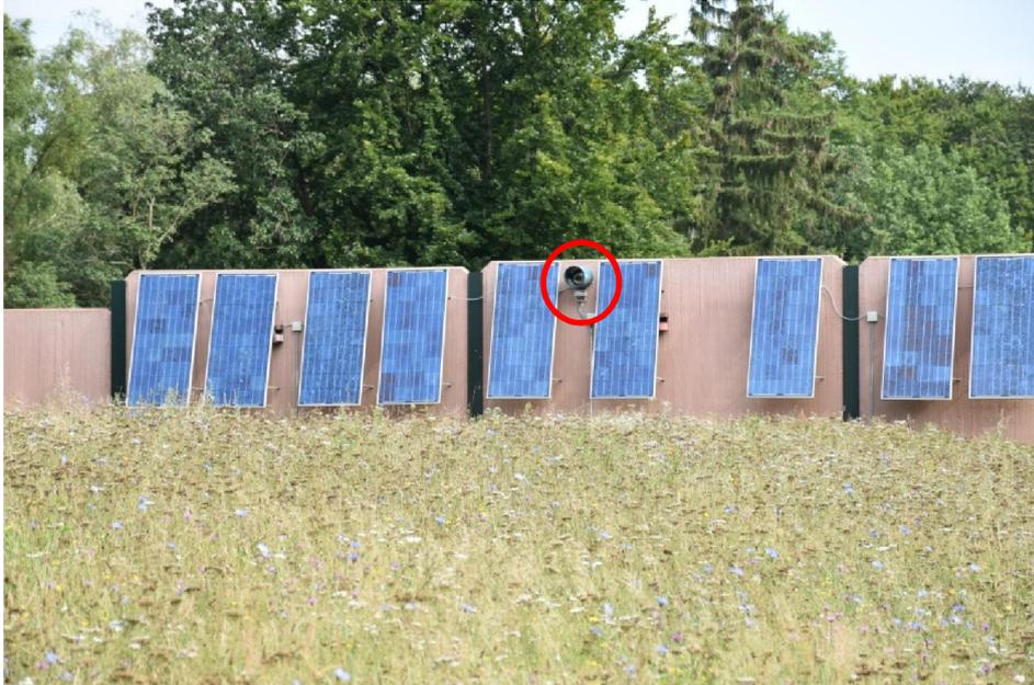
Abb. 4: Irritationsschutzwand mit Kamera und Infrarotscheinwerfer (rote Markierung) sowie neun Solarzellen
